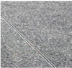
REHACER PAVIMENTO – NUEVO PAVIMENTO DE HORMIGÓN
